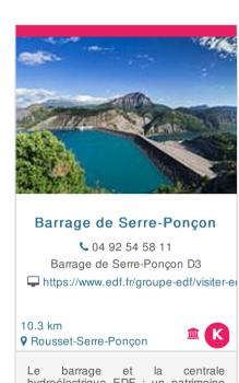
Le barrage et la centrale hydroélectrique EDF : un patrimoine industriel exceptionnel ! C'est l'un des plus grands barrages hydroélectriques en terre d'Europe. Il impressionne par son ampleur : 123 m de haut, 600 m de large et 650 m d'épaisseur !
